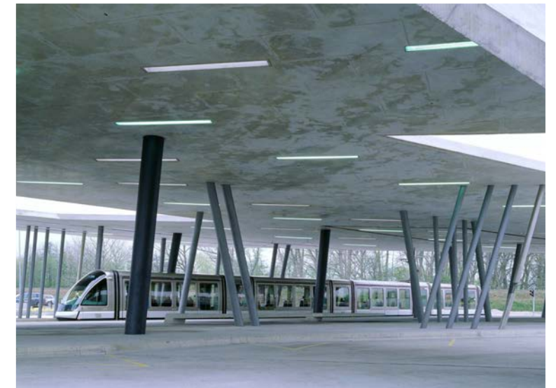
Hoenheim-Nord Pargi&reisi sõlmjaam Strasbourgis avatud 2001a., autor Zaha Hadid arhitektid
